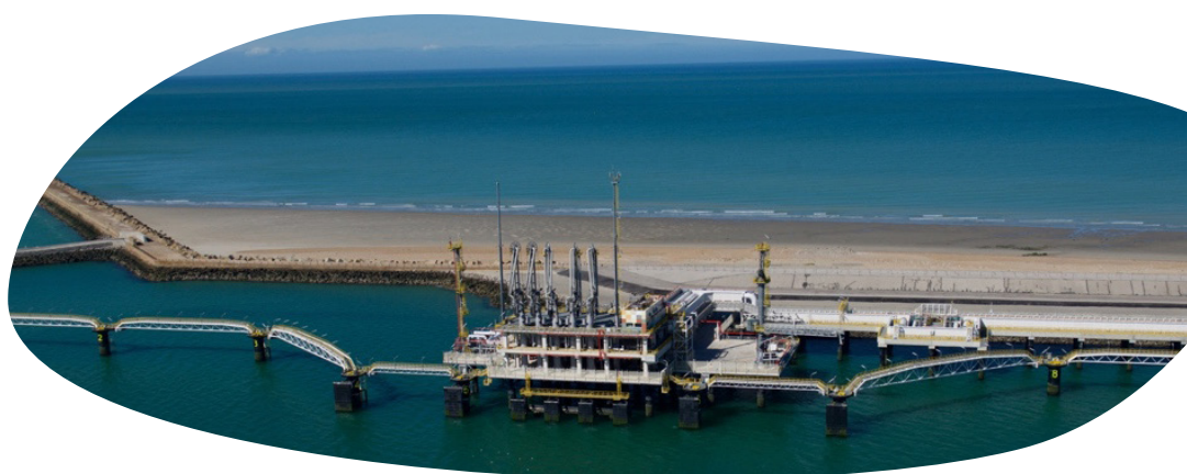
Dunkirk LNG terminal jetty
